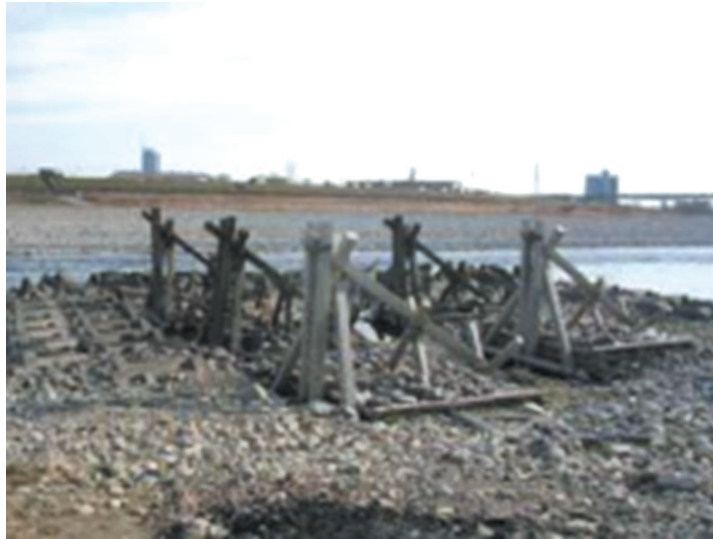
รูปที่ 5 ลักษณะของ Hijiri - Ushi ทำจากคอนกรีตพบที่แม่น้ำ Nagara ที่มา : International Strategy for Disaster Reduction 2008
