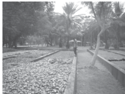
ระบบบำบัดน้ำเสียแบบการใช้พืชน้ำ ที่มา: กลุ่มงานวิเคราะห์คุณภาพน้ำ สำนักงานจัดการคุณภาพน้ำ สำนักการระบายน้ำ กรุงเทพมหานคร
