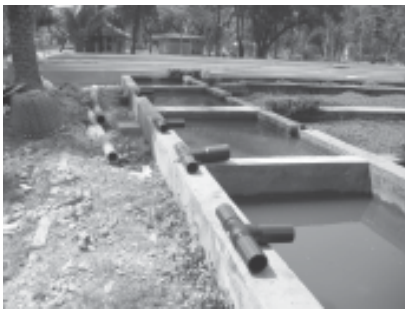
ระบบบำบัดน้ำเสียแบบการใช้พืชน้ำ ที่มา: กลุ่มงานวิเคราะห์คุณภาพน้ำ สำนักงานจัดการคุณภาพน้ำ สำนักการระบายน้ำ กรุงเทพมหานคร
