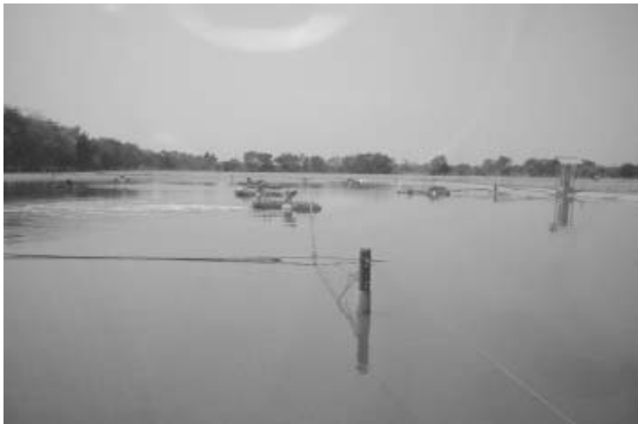
บ่อบำบัดน้ำเสียนขนาดใหญ่ภายในบ่อฝังกลบของเทศบาลเมืองพิจิตร (ภาพโดย ดร.ทรงกฤษณ์ ประภักดิ์)
